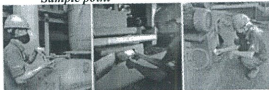
Gambar pengaturan damper dan visual check pada sample point
