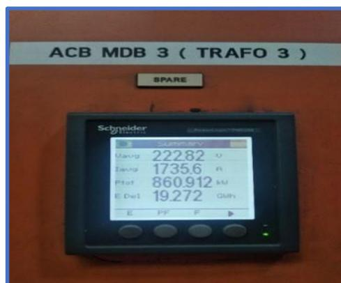
Figure 2. Power Meter Schneider PM5350
