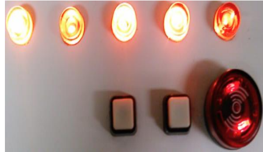
Gambar 4.22 Pengujian masukan PLC pada status LED PLC
