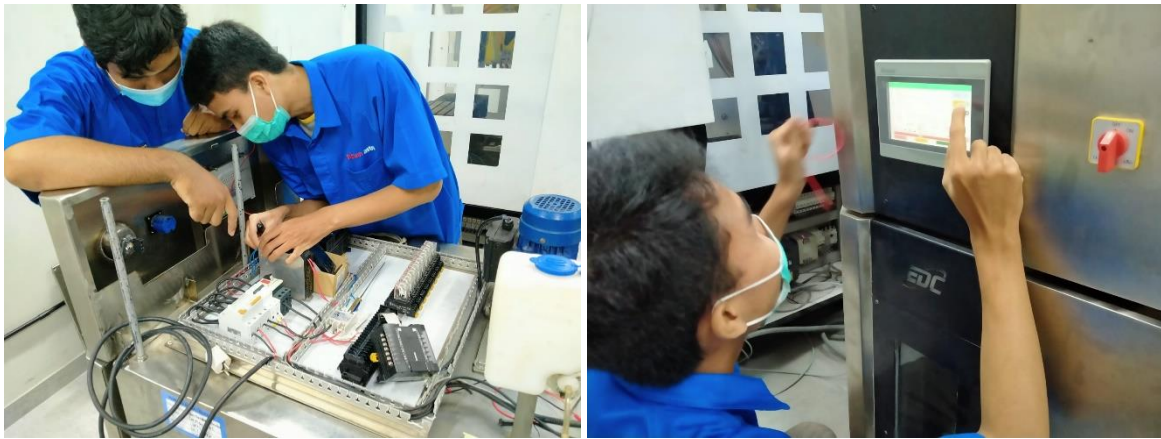
Gambar 11. Proses Penggantian Sistem Elektrikal
