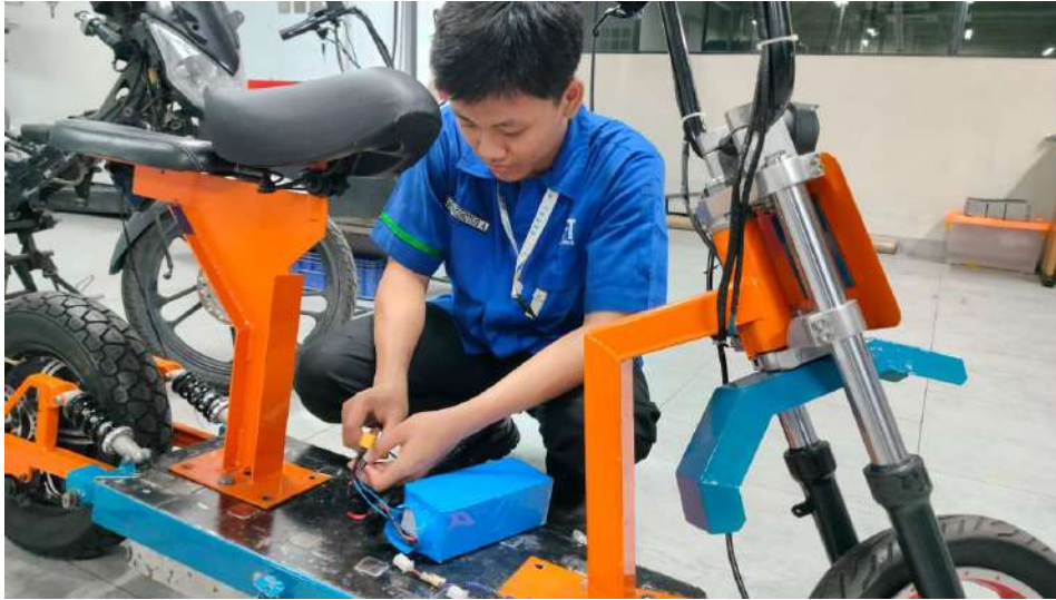
Gambar 16 Pemasangan Battery Pack ke Sepeda Motor AstraTech
